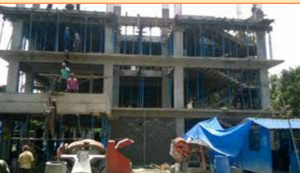
ഗുരുവായൂർ ഗസ്റ്റ് ഹൗസിന്റെ നിർമ്മാണം Basement floor, Ground Floor, First Floor, Second Floor എന്നിവയുടെ സ്റ്റാമ്പുകൾ കോൺക്രീറ്റിങ്ങ് തുടങ്ങിയ ജോലികൾ പുരോഗമിക്കുന്നു.
